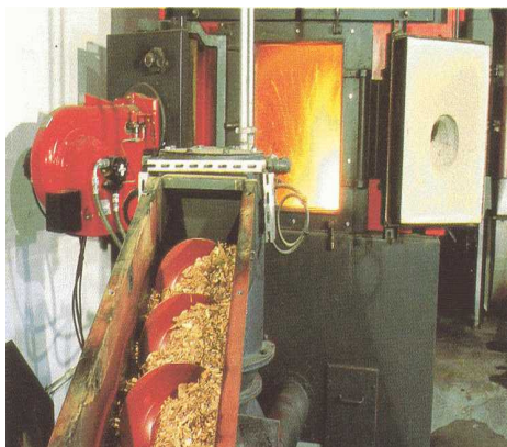
Figur 6.1 viser biokjele med skruemating av flis
